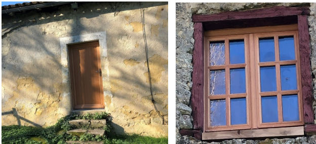
Changement menuiseries Moulin du Mayne
