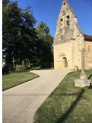
Accès à l'église St Martin + Remplacement vitre de la Sacristie
